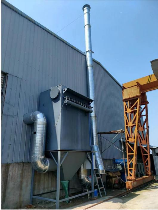
下料工序滤筒除尘+15米排气筒
