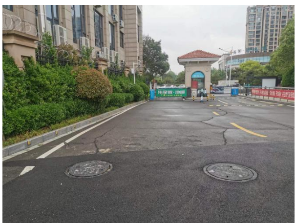
西南门化粪池
