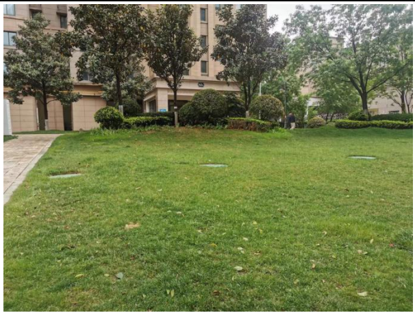
25 号楼北侧化粪池
