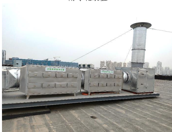
塑封线两级活性炭吸附净化装置
