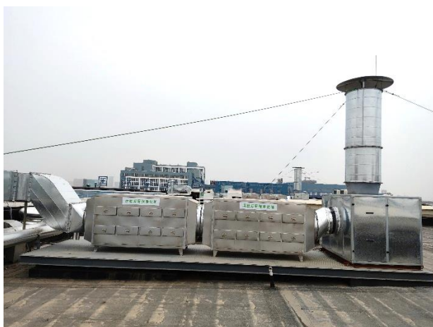
硫化线两级活性炭吸附净化装置
