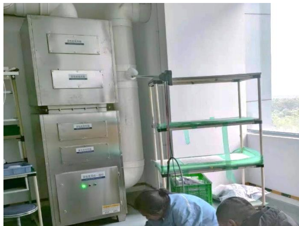
集成设备铆接线涂装+标记印字工序两级活性炭吸附净化装置
